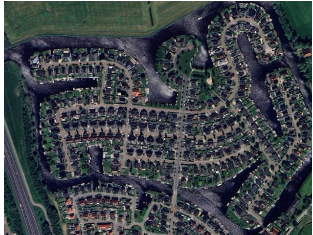
Woningen rechtstreeks aan het water gelegen in Nes
