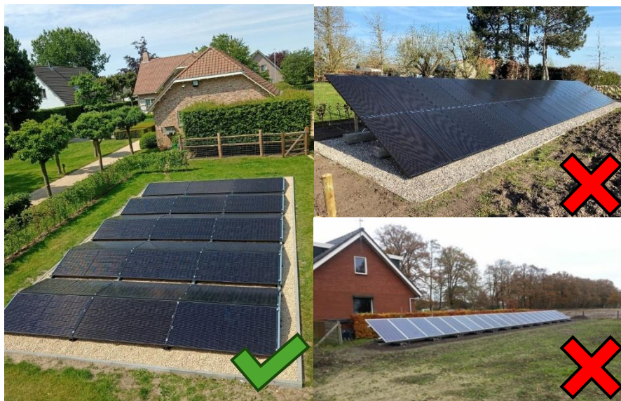
Voorbeelden van plaatsen zonnepanelen op de grond
