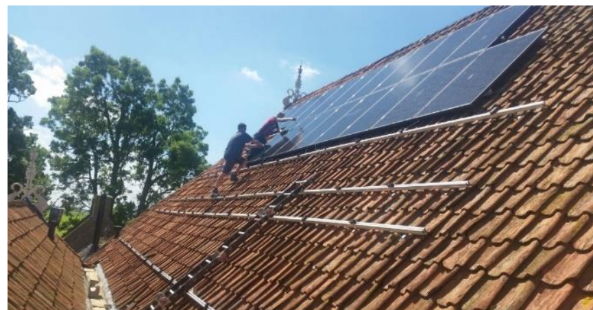
De oude pannen blijven behouden bij het plaatsen van zonnepanelen.
