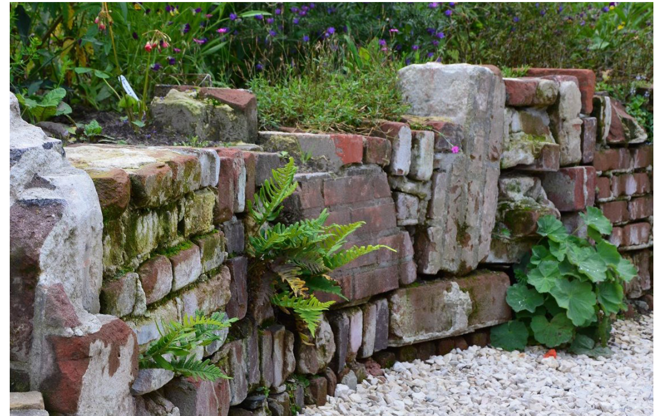
referentie stapelmuur in een Puintuin van Spiker resten
