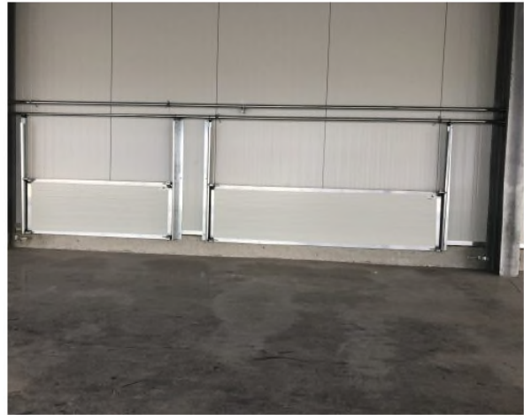
Voorbeeld van stal met geperforeerd damwand aan buitenzijde wintergarten
