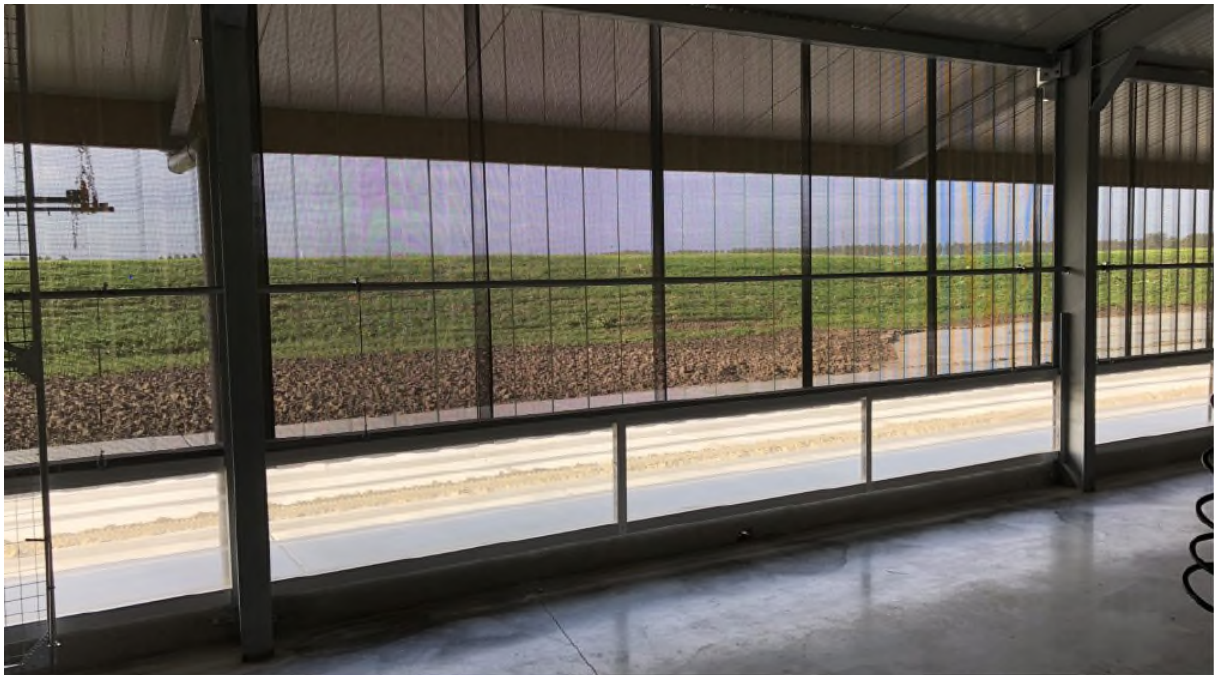
Voorbeeld van stal met geperforeerd damwand van binnenuit gezien
