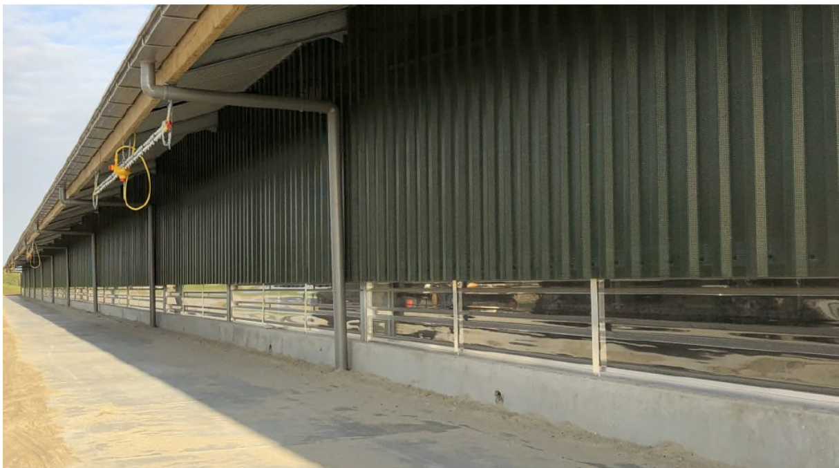
Voorbeeld van stal met geperforeerd damwand aan buitenzijde wintergarten
