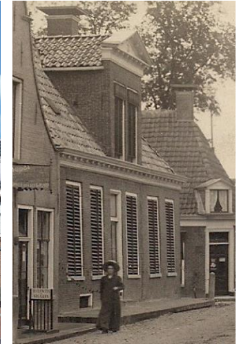
Voorbeelden van passende zonwering: links persiënnes bij Hogepol 18 en rechts persiënnes en houten louveres met louverkasten. Rechtsonder persiënnes en markiezen. Linksonder PV panelen op een plat dak uit het zicht (Vleesmarkt 7)
