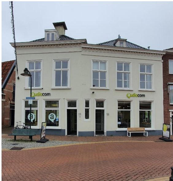
Samenstelling van twee panden waarbij de pleisterlaag is ingezet om er een statig geheel van te maken. Overigens is rond 1995 een niet passende harde toplaag opgezet. Keppelstraat 13 en 15.
