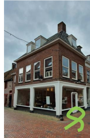
Pand uit 1958 met bijzondere puiconstructie van beton
