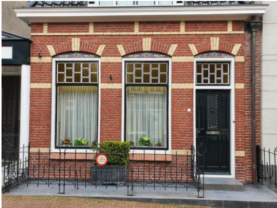
Een fraai gereconstrueerde stoep met art-deco hekwerk passend bij de stijl van de woning (Hogepol).
