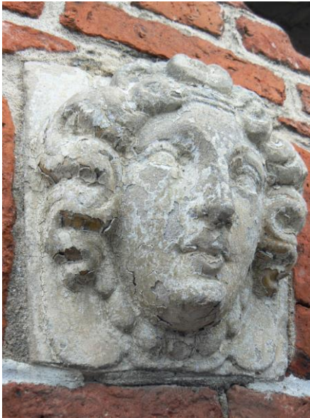
Zandsteen sluitsteen boven een raamopening van het Admiraliteitshuis (1618) aan de Lange Oosterstraat.
