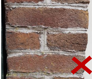
Bij metselwerk uit 1880 waar een gesneden voeg aanwezig was, is een grove voeg van cementspecie met dagstreep aangebracht.
