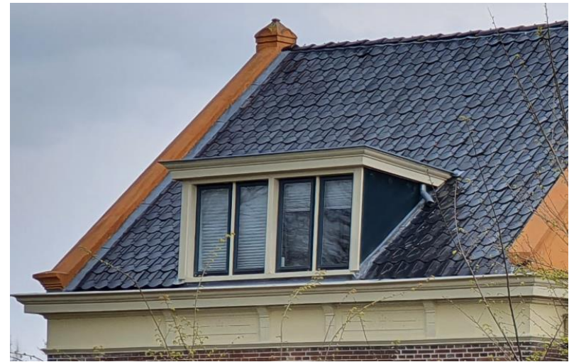
Links de uiterst zeldzame ruitvormige Helderpan op Aalsumerpoort 18 (ontwikkeld en geproduceerd door de Dokkumer pannenfabriek van Helder die ook de steenfabriek in Oostrum in eigendom had), en rechts de eveneens zeldzame Lucas IJsbrand pan van Tigchelaar uit Makkum.
