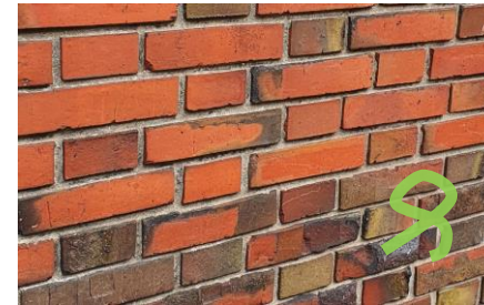
Gaaf metselwerk uit de jaren '30 met terugliggende voeg en plint van mondsteen (gesinterd doordat ze dicht bij het vuur stonden)
