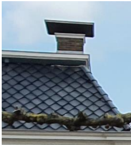
Links de uiterst zeldzame ruitvormige Helderpan op Aalsumerpoort 18 (ontwikkeld en geproduceerd door de Dokkumer pannenfabriek van Helder die ook de steenfabriek in Oostrum in eigendom had), en rechts de eveneens zeldzame Lucas IJsbrand pan van Tigchelaar uit Makkum.
