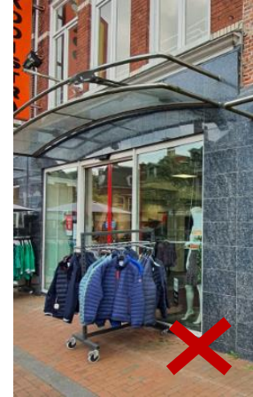
Detonerende pui met vloertegels op de gevel.
