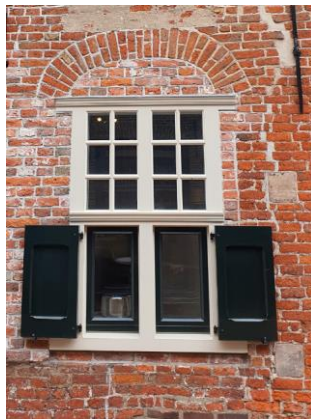
Reconstructie van een kruiskozijn in 16 e eeuwse metselwerk
