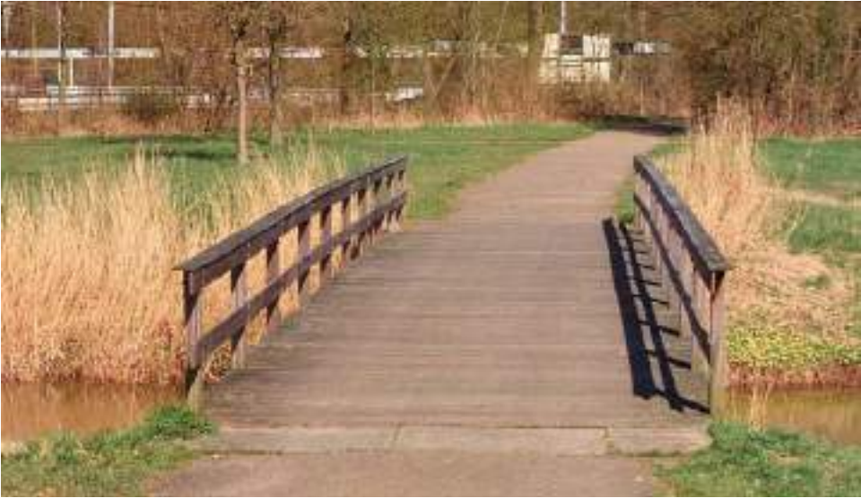
Bestaande houten loopbrug Tolhuispark
