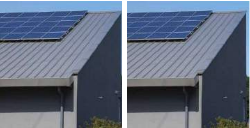
Zonnepanelen op een clubgebouw
