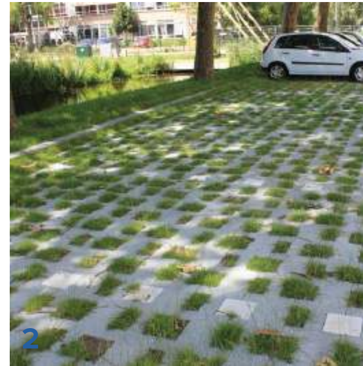
Parkeervakken - Grasbetontegel met vak aanduidingstegels
