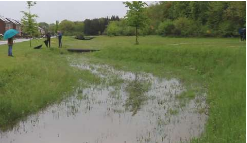
Afvoer hemelwater in laagtes.
