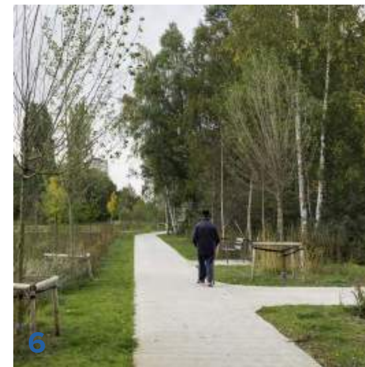
Wandelpad van gestort en gebezemd beton
