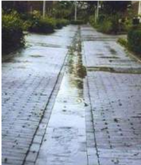
Hemelwater kolkloos afvoeren naar een laagte berging of oppervlakte water.
