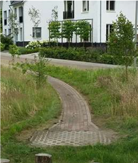
Hemelwater kolkloos afvoeren naar een laagte berging of oppervlakte water.
