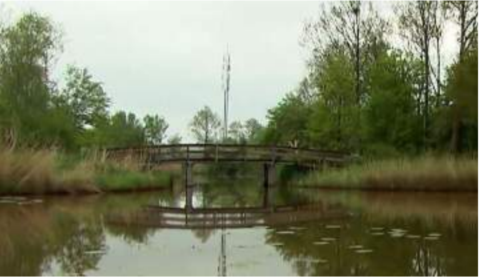
Bestaande houten loopbrug over de plassen van het Tolhuispark
