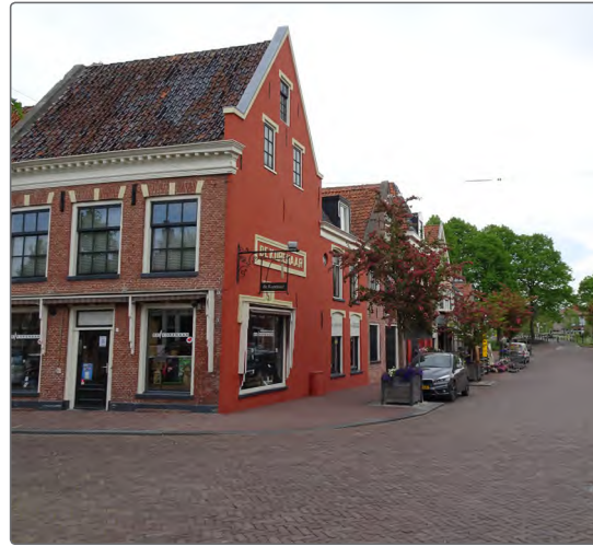
Franeker | monumentaal gevelbeeld
