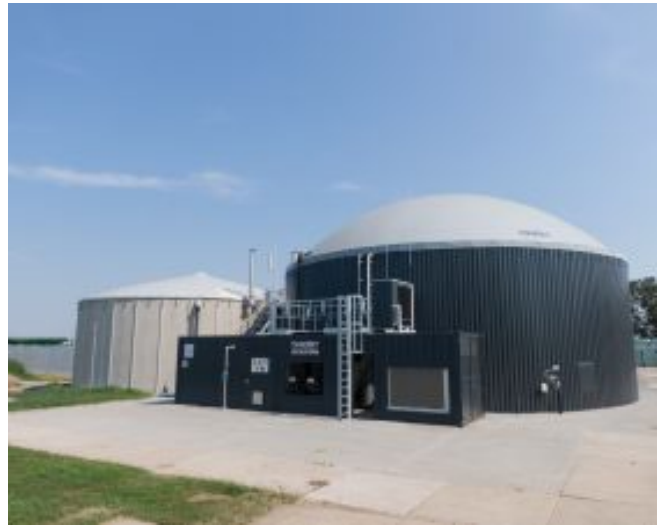
Figuur 2. Mono-mestvergistingsinstallatie Koudum
