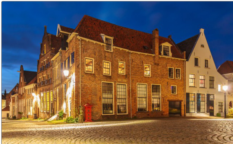
Deventer | Aanlichten van de straat
