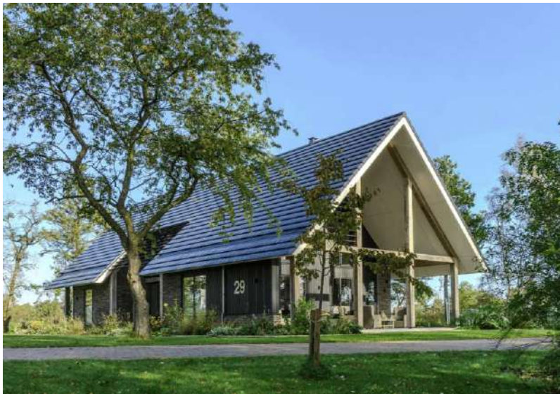
Ruime overstekken (bron: Mestemaker architecten )
