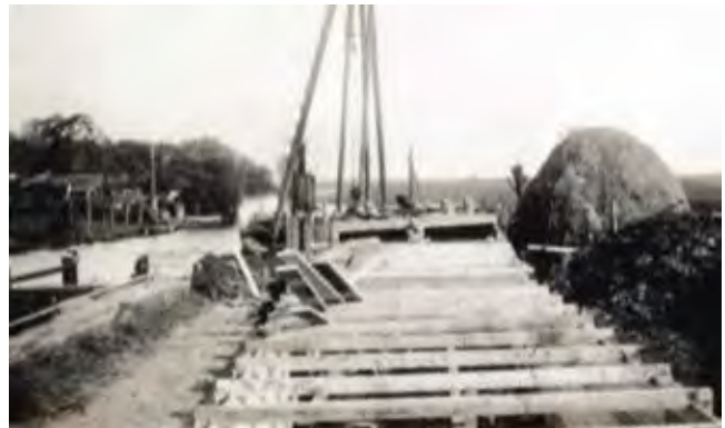
Aanleg van het hulpgemaal in 1930
