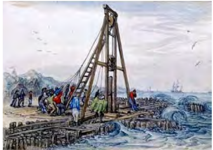
Heiwerk met behulp van mankracht
