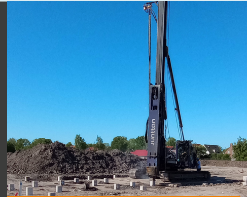
Het plaatsen van heipalen in Noarderstek
