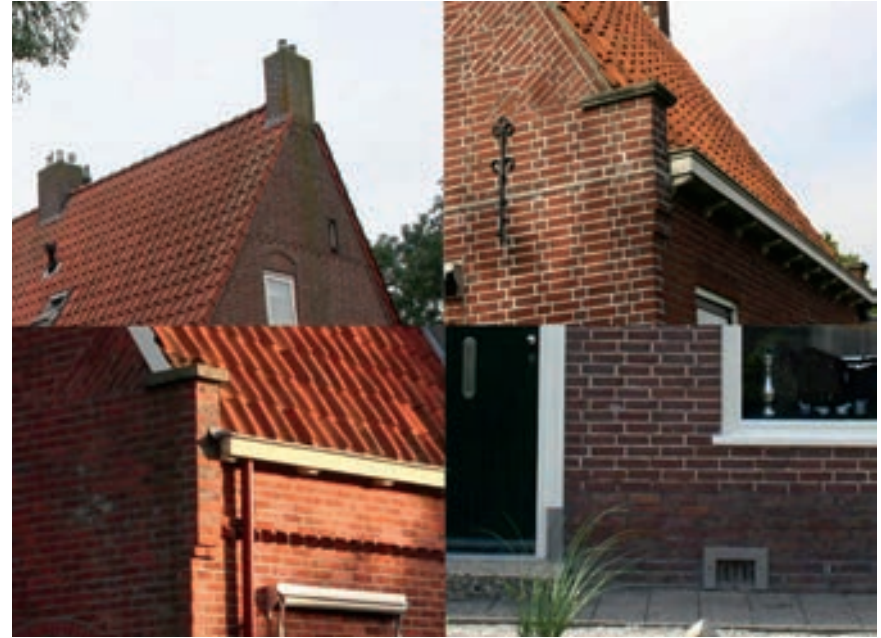
Soms een toepassing van (ambachtelijke) details in het metselwerk: boerenvechtwerk, trasramen en "muizentandjes"
