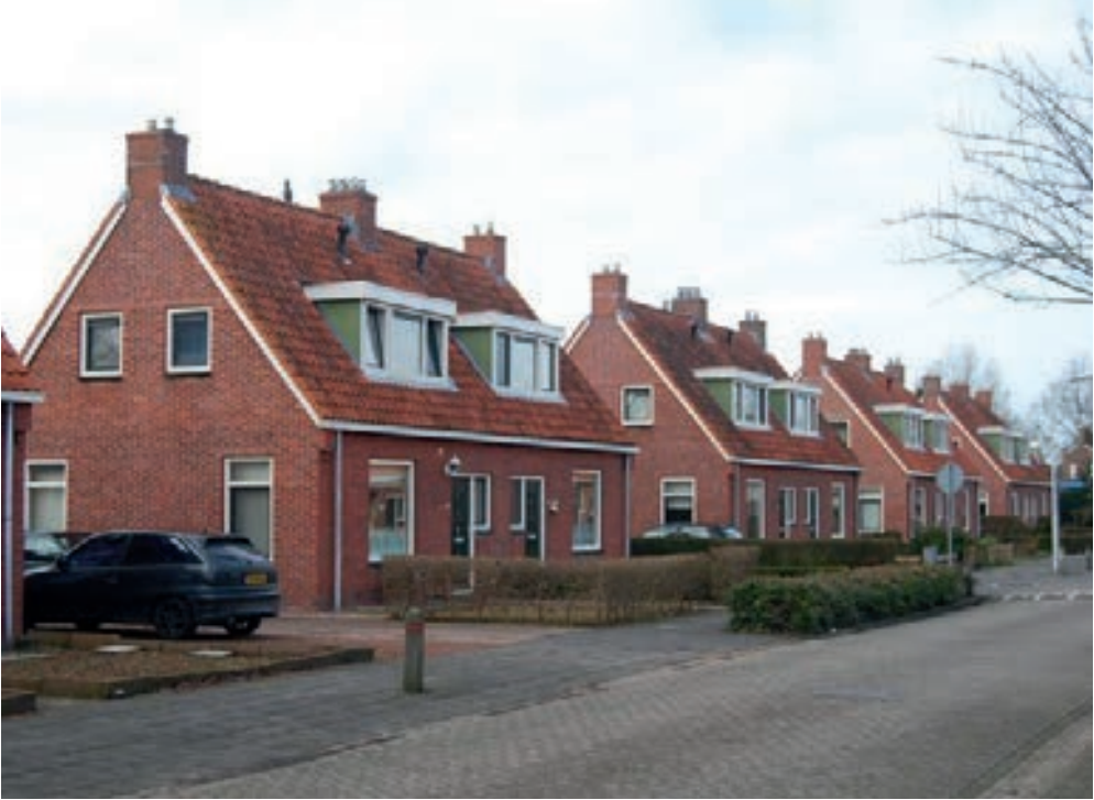
Bestaande situatie Balk, Julianastraat
