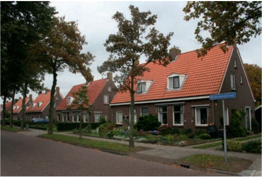
Bestaande situatie Sint-Nicolaasga, Wilhelminastraat
