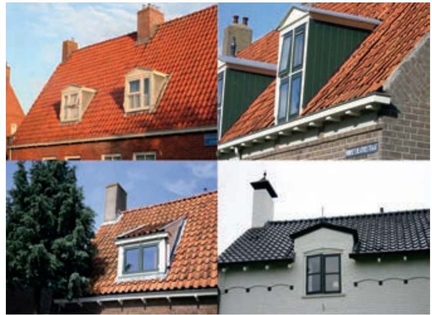
Incidenteel voorkomende bijzondere dakkapellen: verdeling in het kozijn, door de goot gezakt of uit het dak gesleept
