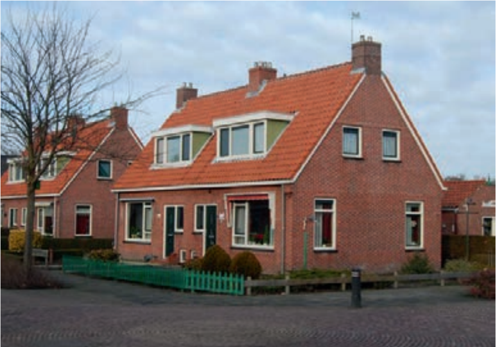
Bestaande situatie Balk, Julianastraat
