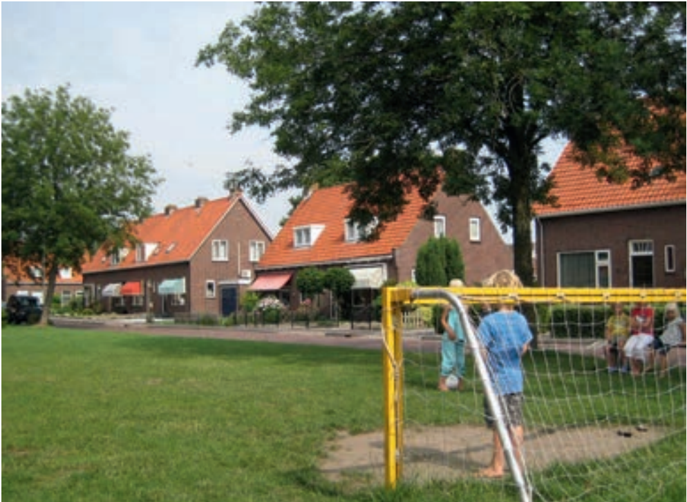
Bestaande situatie Lemmer, Willem Barendszstraat
