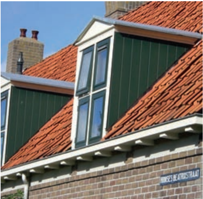
In Harlingen zien we aan de dakvoet een bakgoot op klossen
