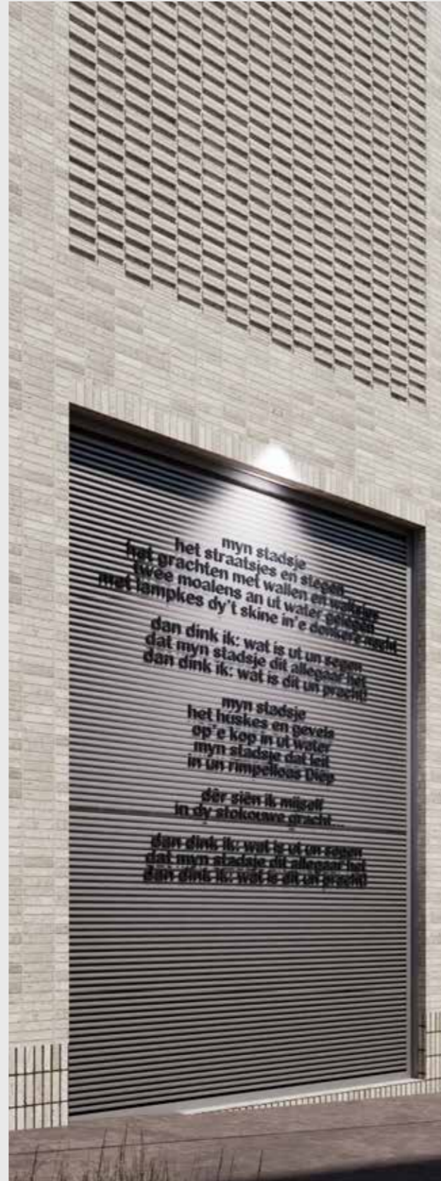
speciaal patroon en rooster op de dichte gevel
