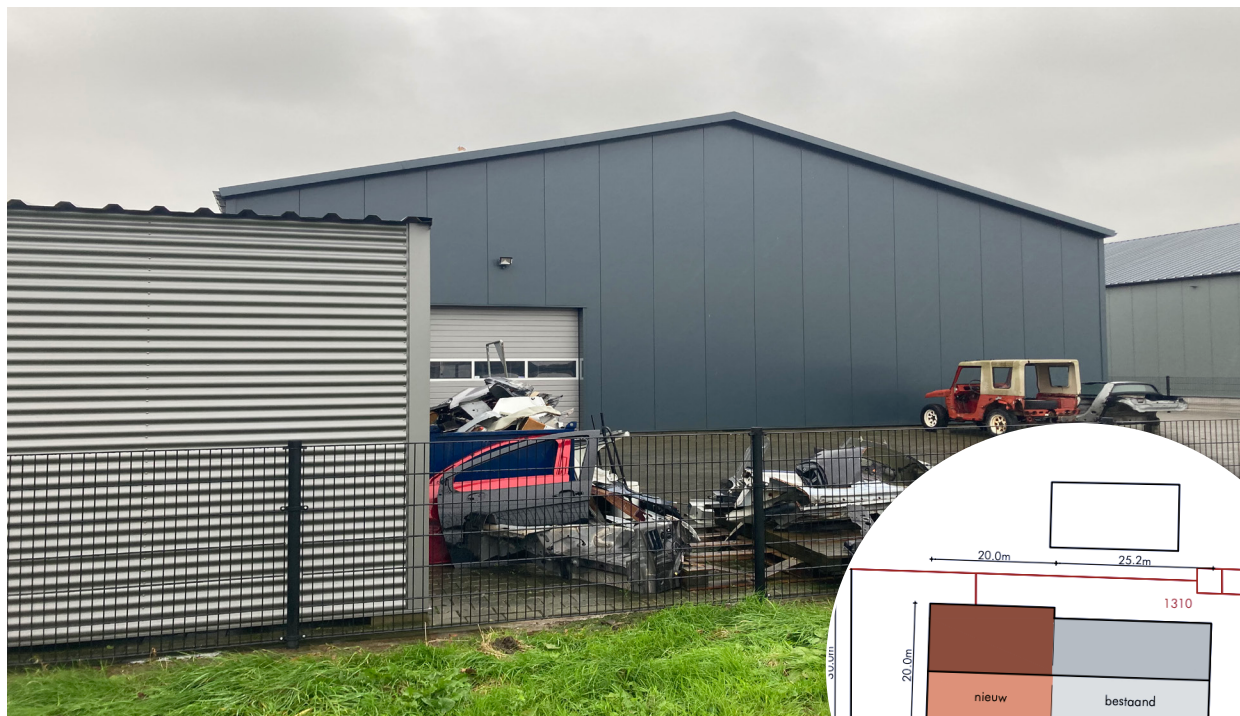
Figuur 1. achterzijde bedrijfspand met links de overkapping/schuur. Inzet: weergave bestaande en nieuwe situatie. Bron: DMA bouwkundig bureau.
