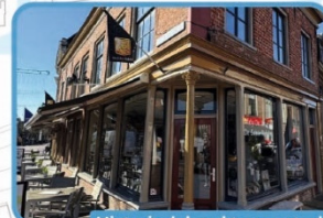
Historisch karakter versterken door subsidie (SOM) voorbeeld van een pand aan de Grote Breedstraat
